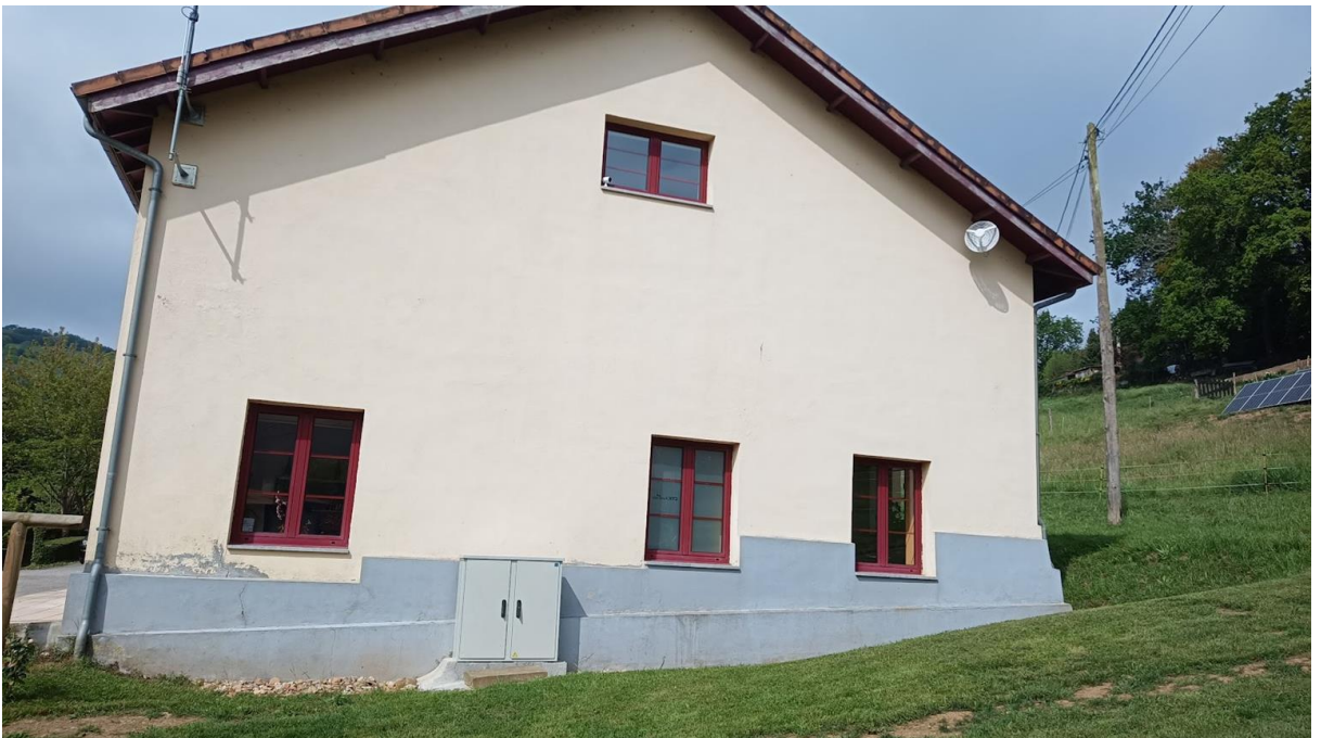
Fachada lateral donde se ubica el cuadro principal exterior del edificio. Desde éste será necesario la instalación de canalización enterrada hasta fachada posterior. Hasta éste cuadro existe canalizaciones enterradas hasta los contenedores donde será instalado el SAI.
