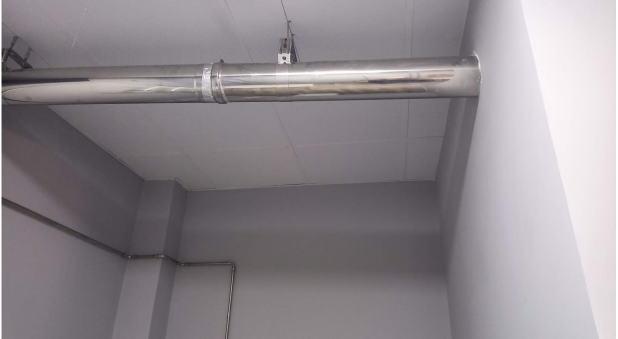
Tramo de techo desmontable desde pared exterior (izquierda de la foto) a hueco del armario (lado derecho de la foto).
